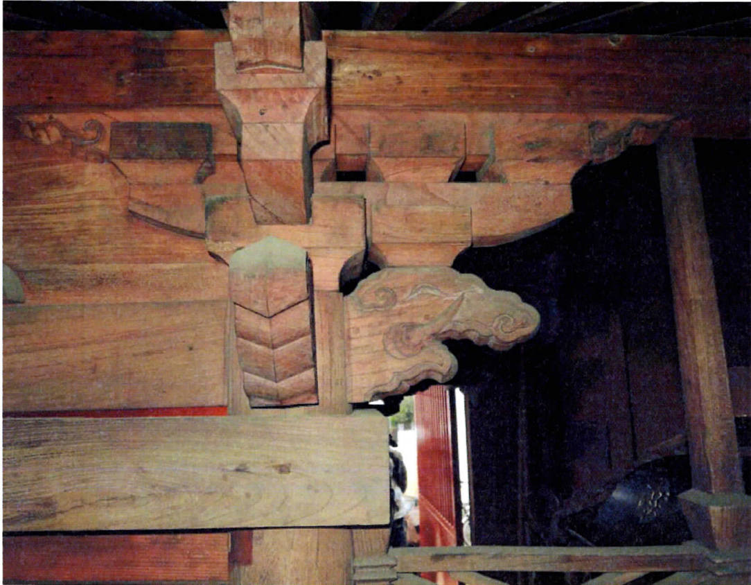
18. 日枝神社本殿 身舎背面木鼻および組物1 身舎柱上の組物は絵様実肘木付の連三斗形式で、庇柱上組物と同じ形式である。桁行の木鼻は、正面側と同じ象鼻形状である。
