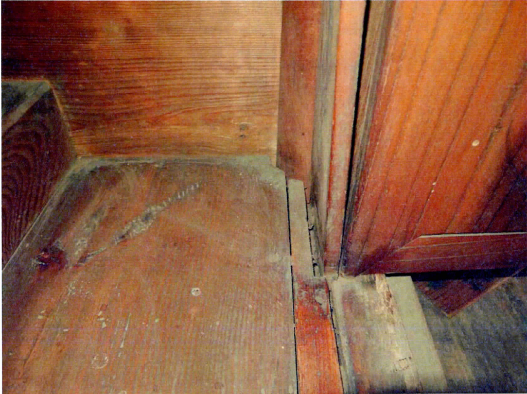
1 4. 日枝神社本殿 身舎床面（扉と小脇板とのおさまり） 柱・扉・小脇板・半長押などは櫨材で拭き漆仕上げしているようである。一方、壁板はスギ（天井板も杉）、床板と壇框は檜で、いずれも素木である。
