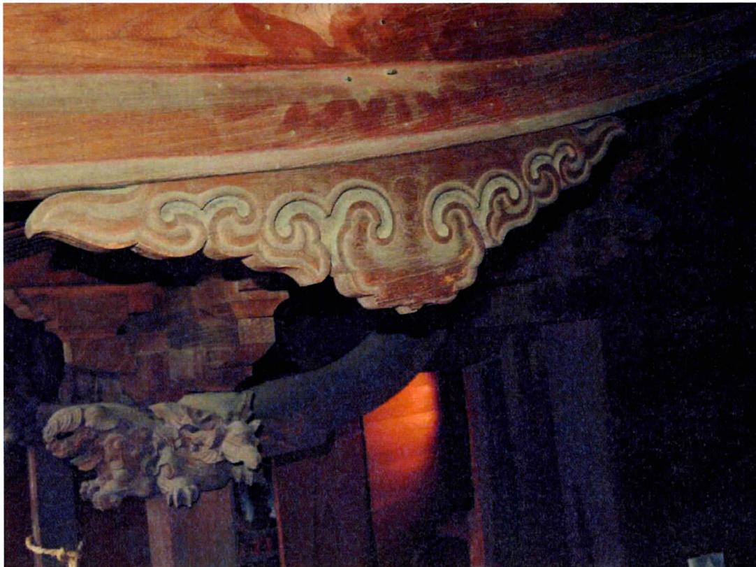
3 1. 日枝神社本殿 正面破風板と兎の毛通し 庇軒桁部の懸魚は「兎の毛通し」形式とする。その上方に痕跡を有する破風板飾り金具は、宝輪と剣をモチーフとした形式（大棟の棟飾り類似）と考えられる。
