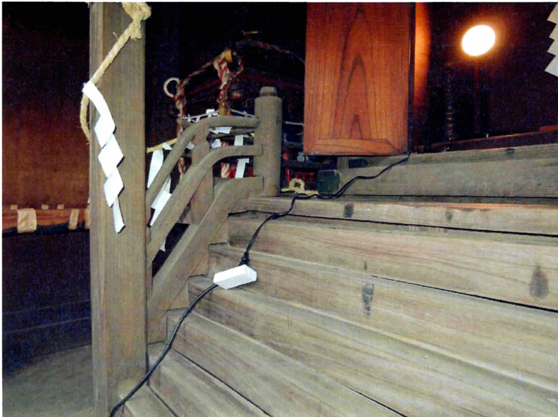
6. 日枝神社本殿 庇木階(ヒサモカイ)と登り高欄(ノボリコウラン) 高欄の擬宝珠(ギボシ)は宝珠が欠失している。
