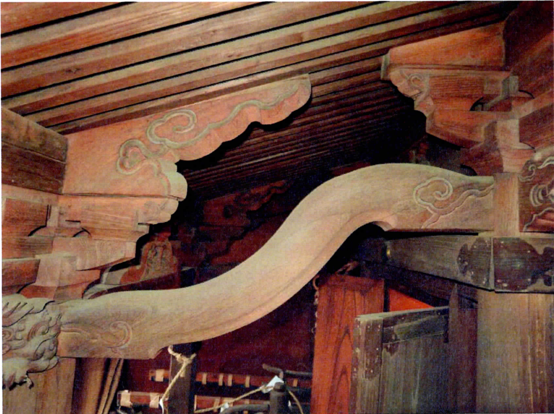
8. 日枝神社本殿 庇架構
