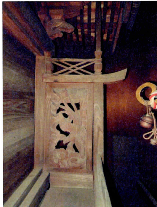
1 5. 日枝神社本殿 身舎側面後端の脇障子 脇障子上部は竹の節と吹き寄せ襷による欄間を設け、外側の竹の節は部材頂を延ばして背面軒桁を支承する。脇障子板は櫨材一枚板に透かし彫り彫刻を施す。
