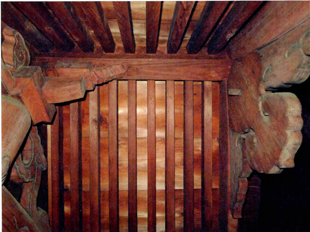
2 6. 日枝神社本殿 身舎妻組上方の化粧棟木見上げ
