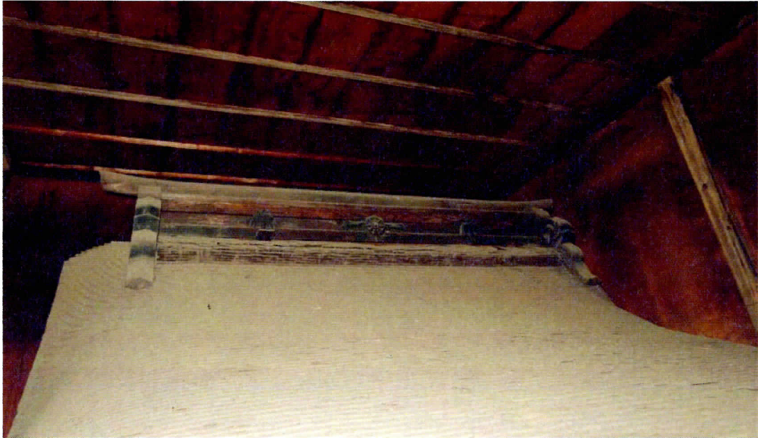
27. 日枝神社本殿 屋根大棟
