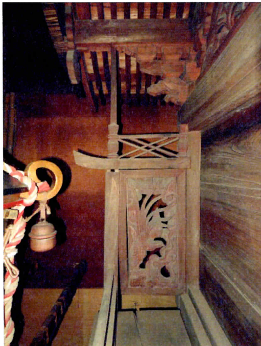
1 5. 日枝神社本殿 身舎側面後端の脇障子 脇障子上部は竹の節と吹き寄せ襷による欄間を設け、外側の竹の節は部材頂を延ばして背面軒桁を支承する。脇障子板は櫨材一枚板に透かし彫り彫刻を施す。
