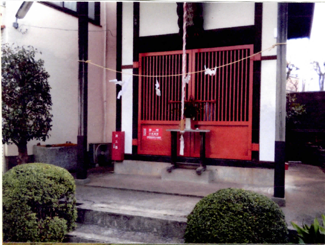
1. 日枝神社本殿 覆屋全景
