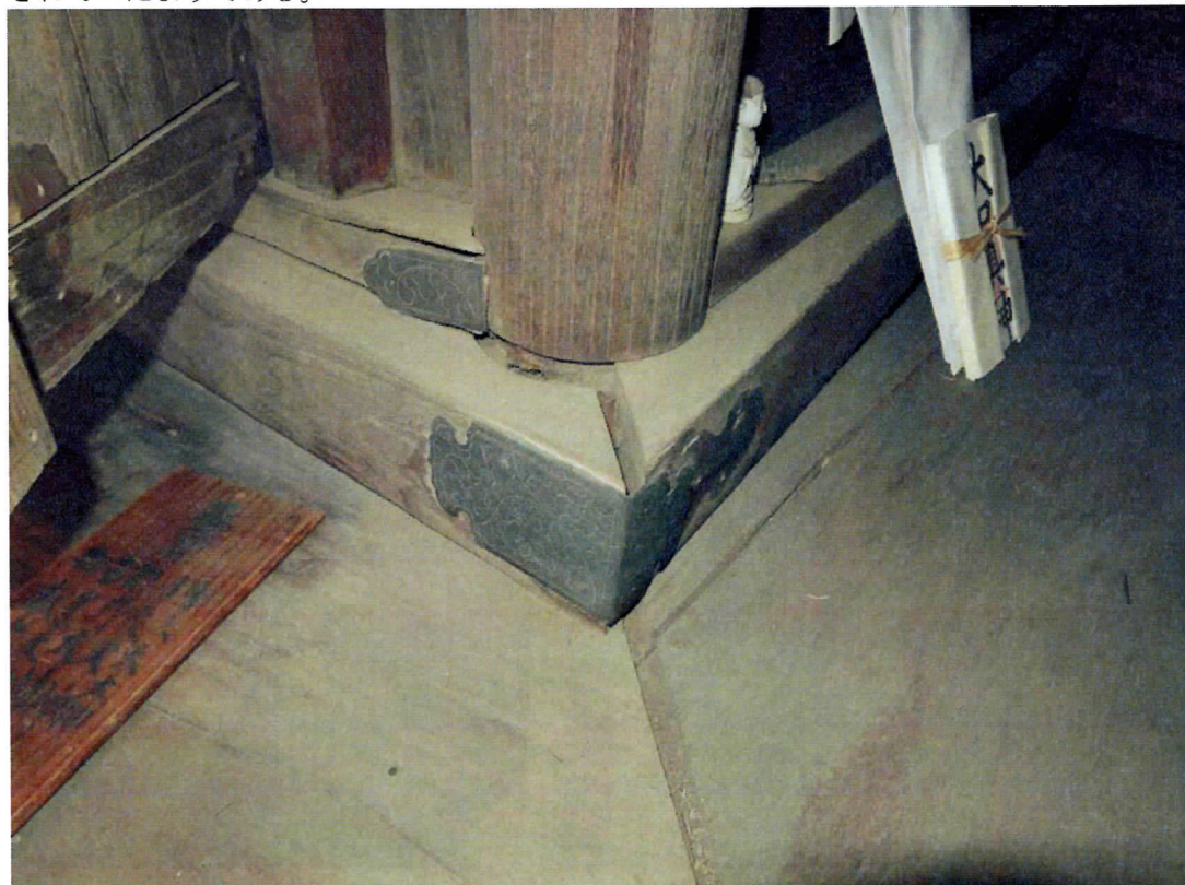
1 3. 日枝神社本殿 身舎正側面切目長押 切目長押の隅の金具は、本来の形状でなく、間に合わせ的に補足している。
