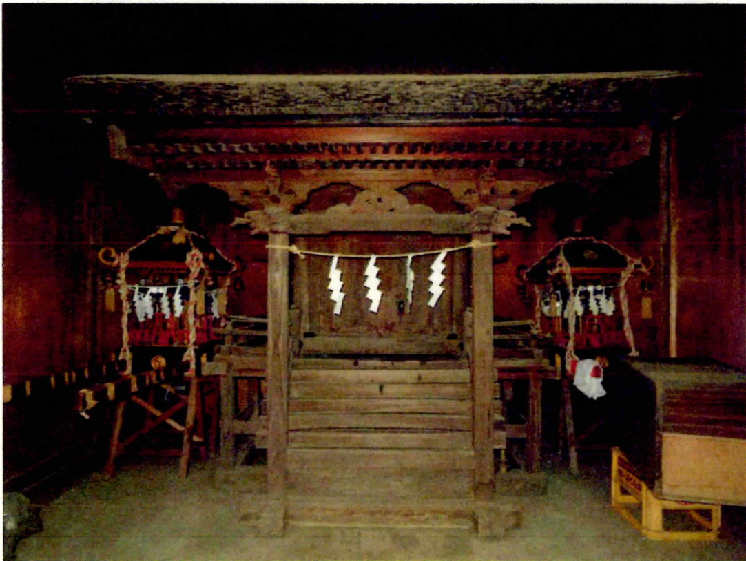
2. 日枝神社本殿正面全景
